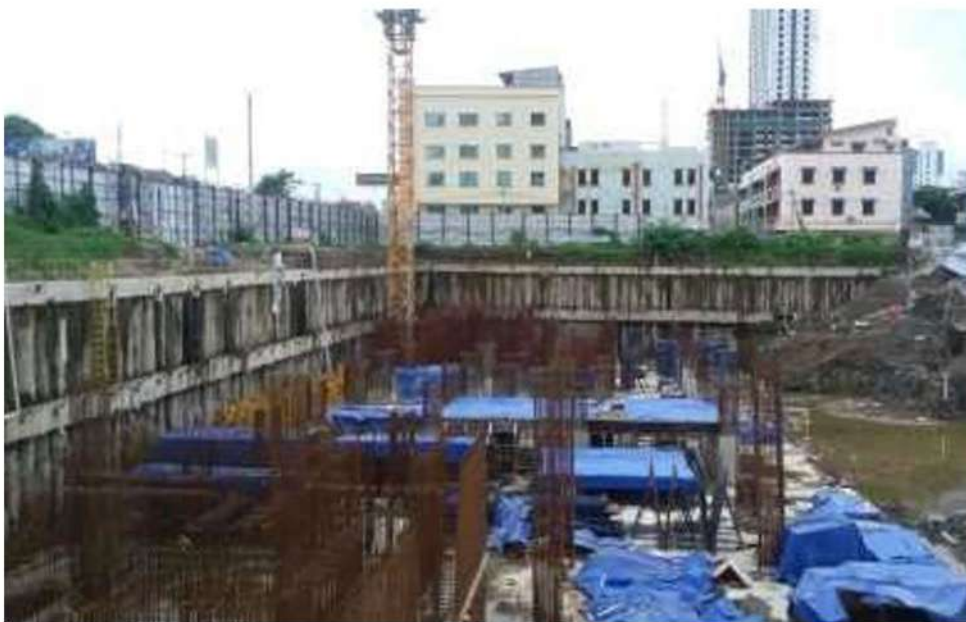
*gambar pada saat pengerjaan pondasi
